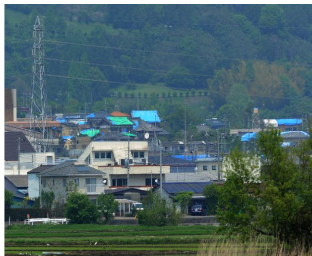
雨風で屋根をブルーシートで補完
