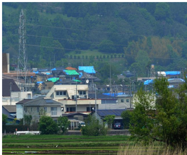
雨風で屋根をブルーシートで補完
