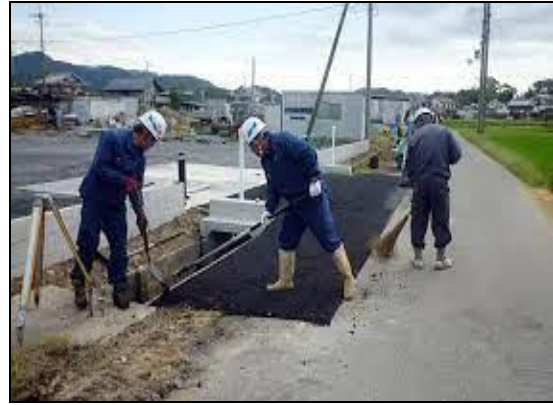
(工事現場 イメージ)
