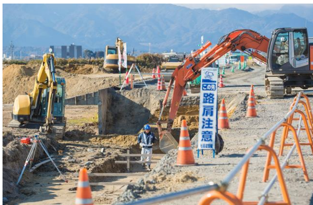
(工事現場 イメージ)
